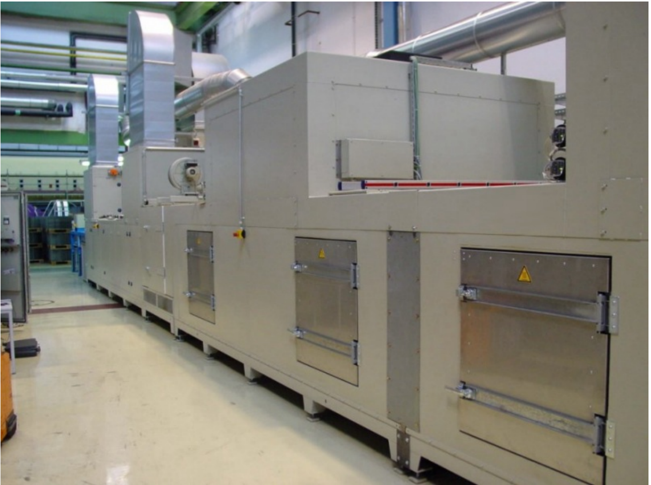
KNÖDEL Segmentbeschichtungslinie, Lacktrockner und Kühlzone
